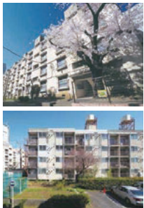
中野駅南口に、昭和26年に建設された 「中野住宅」
